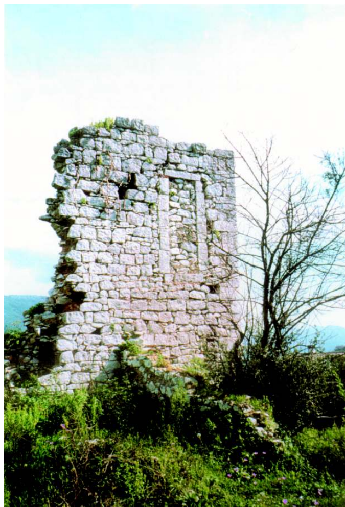
Priverno. Particolare del complesso architettonico di Colle S. Vito.
